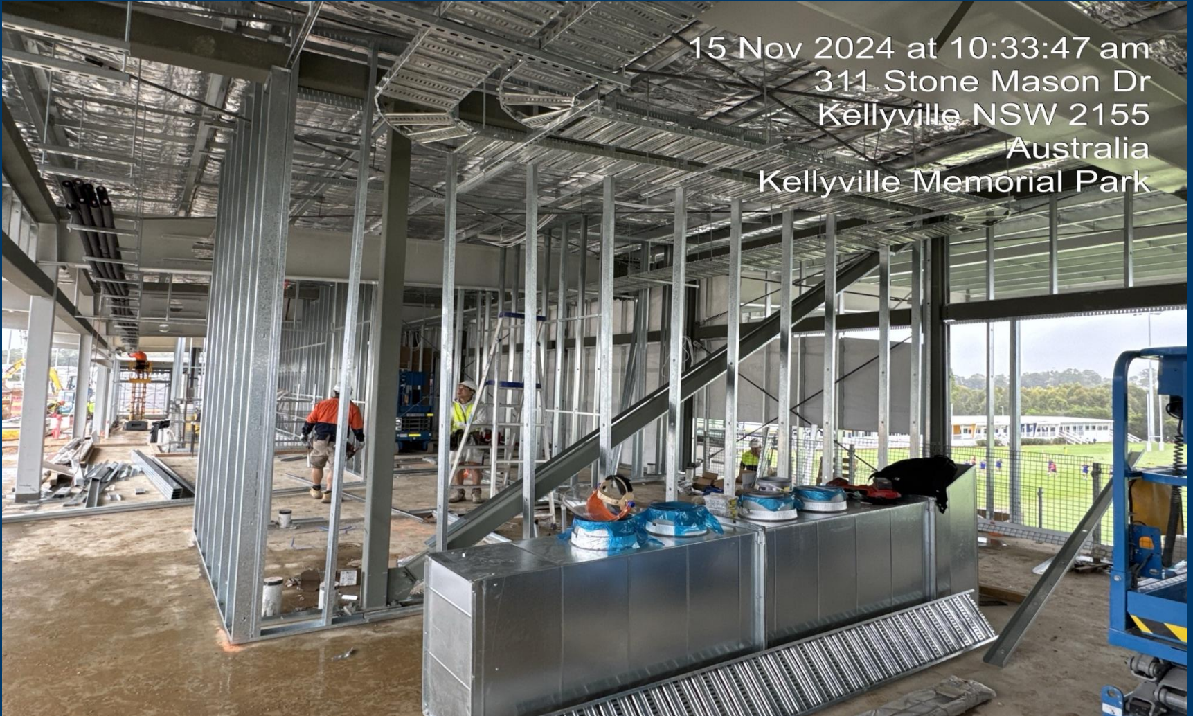
Building A – Commencement of Framing (GF Pour 3)
