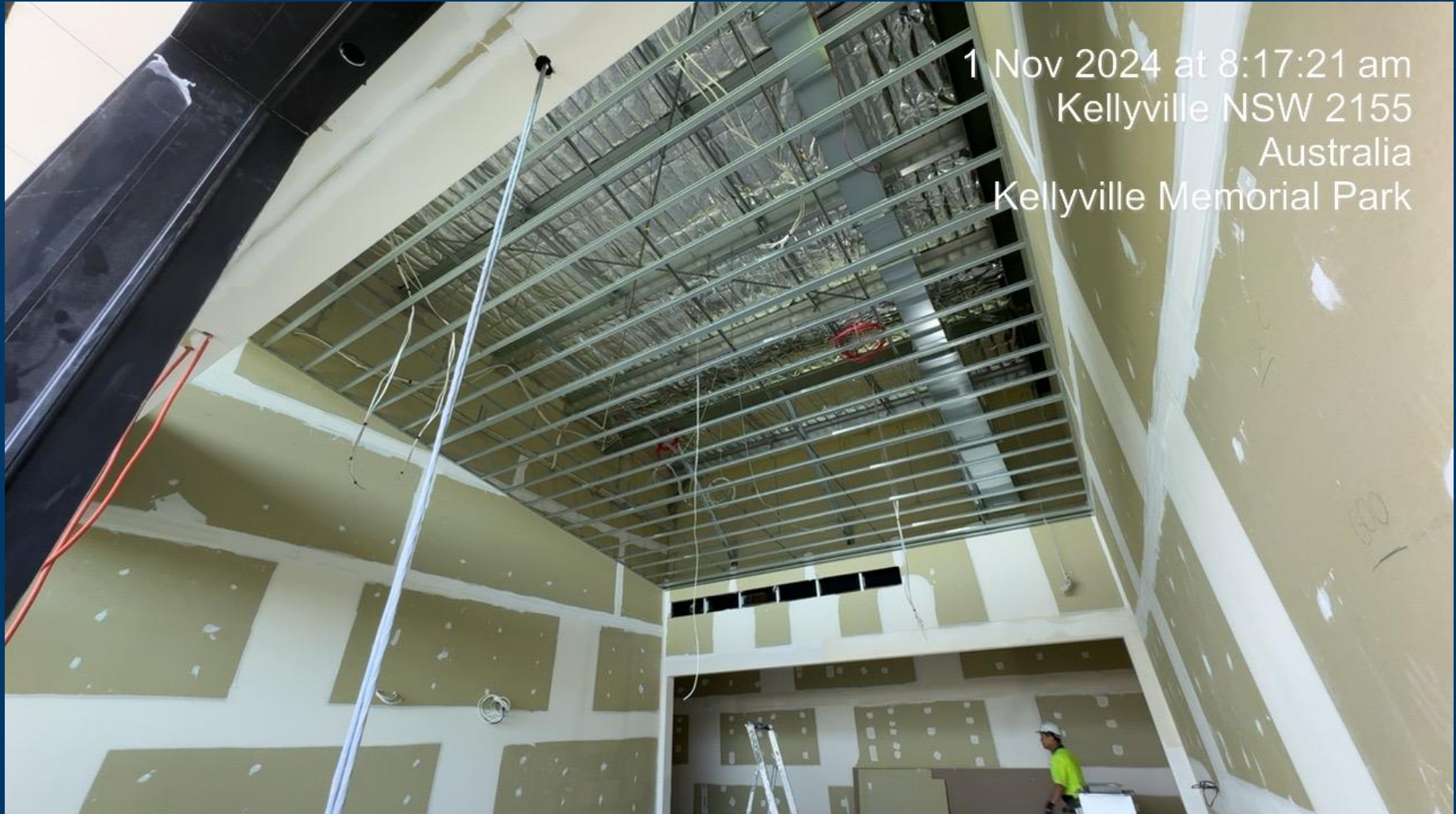
Building B – Ceiling Framing (GF Pour 3)
