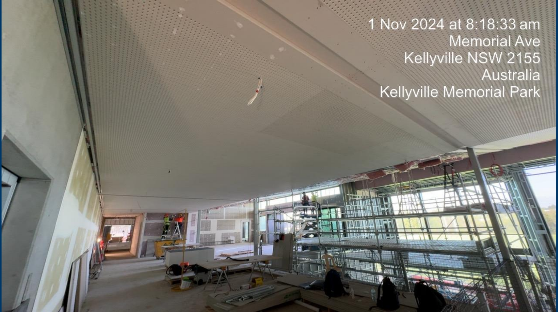
Building B – Ceiling Sheeting (GF Pour 2)
