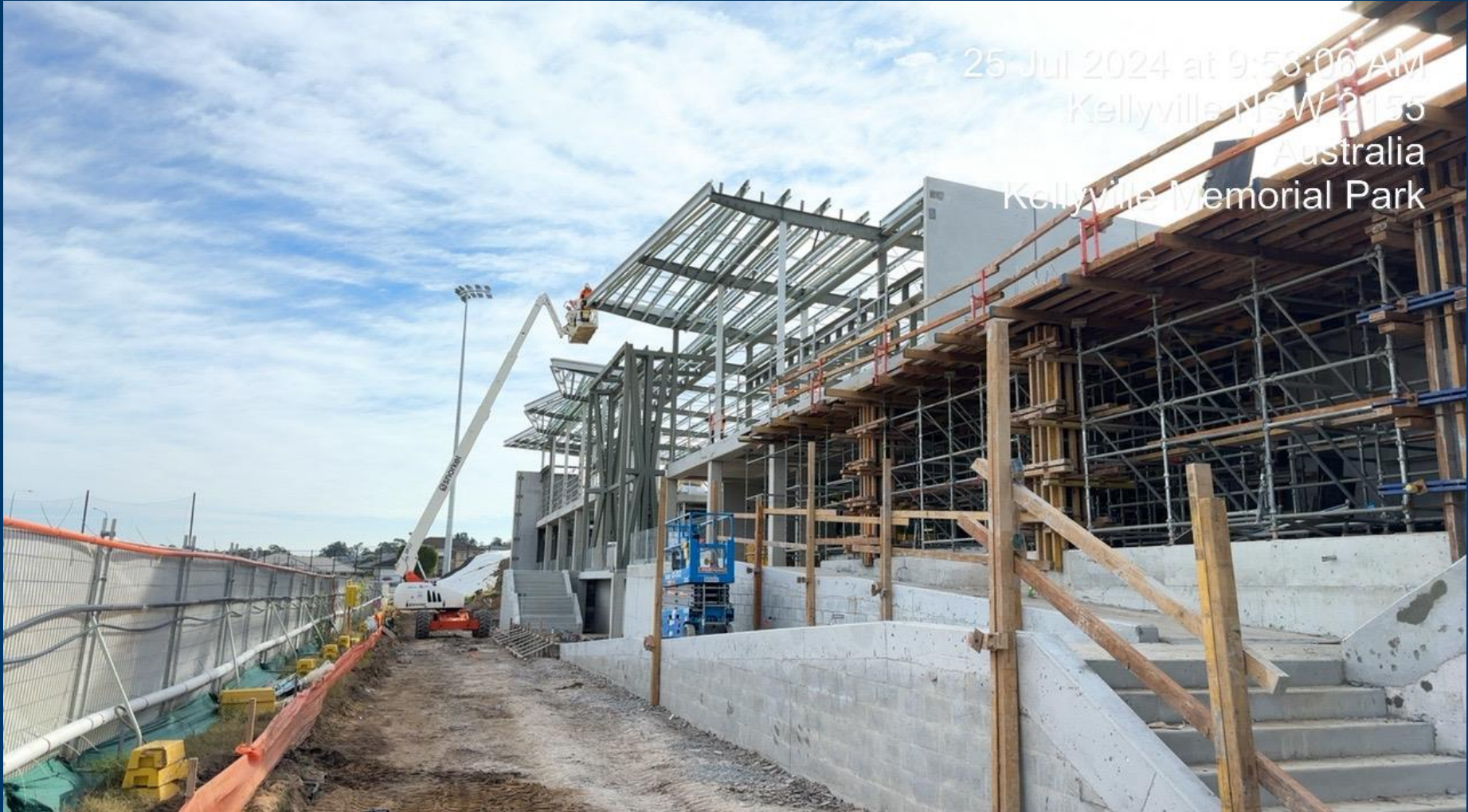
Building B – Structural Steel Installation to Upper Floor Pour 1 and Pour 2
